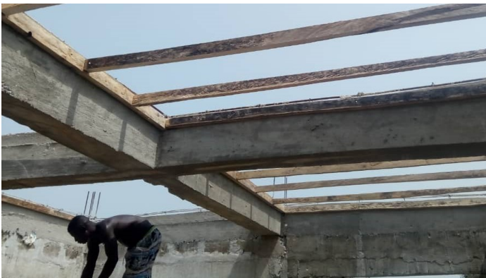
Auf die Betonträger werden Balken gelegt
