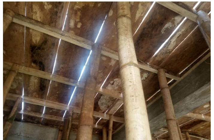
Jetzt ist das Dach für den nächsten Schritt vorbereitet
