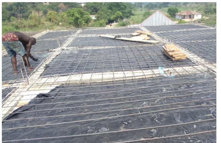
Viel Eisen sorgt für die Festigkeit bevor die Decke gegossen wird.
