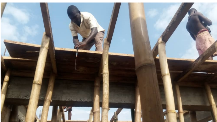
Nachdem die Holzstützen gesetzt sind, kommen Bretter darüber
